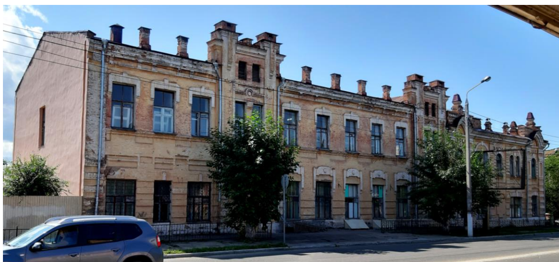
Северо-восточный фасад. Вид с востока
