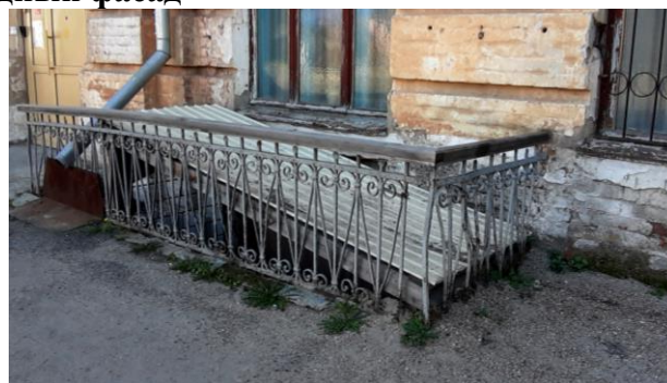
Ограждение прямка входа в подвал
