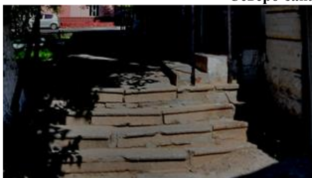
Лестница на тротуаре по ул. Нерчинская
